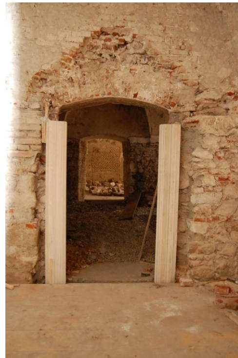
Demolări pentru refacerea golurilor de trecere, parter Corp A - MUZEUL CETĂȚII
