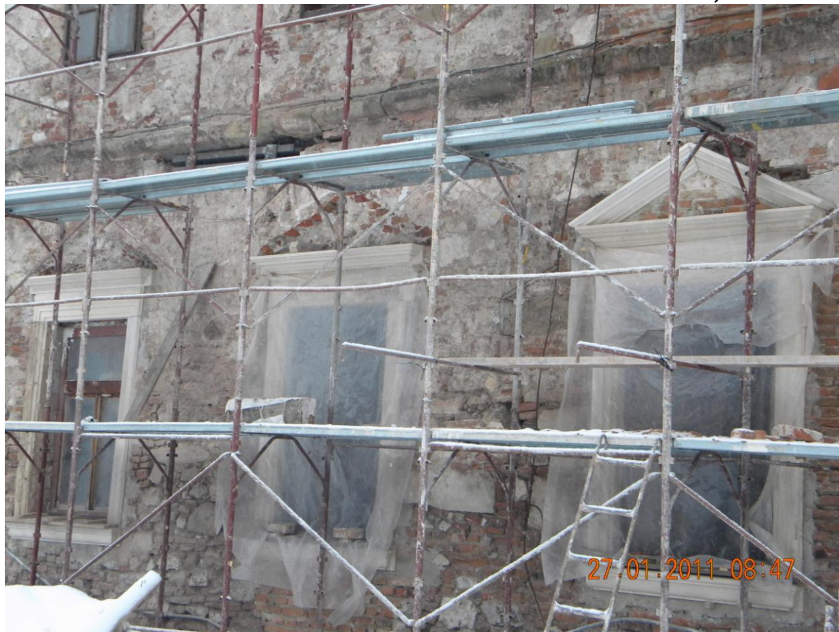
Restaurare/montare ancadramente de piatră ferestre la parter Corpului A(zona "Sălii cu Grifoni") - MUZEUL CETĂȚII
