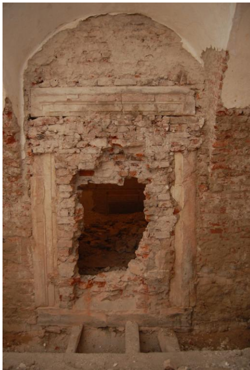
Demolări pentru refacerea golurilor de trecere, parter Corp A - MUZEUL CETĂȚII
