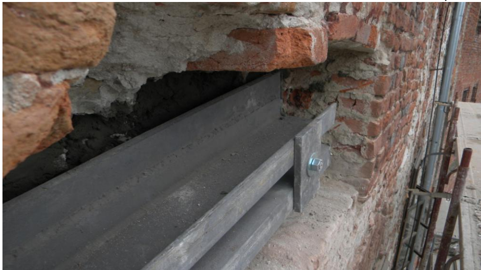
Tirant montat pe fațada vestică Corp A-MUZEUL CETĂȚII
