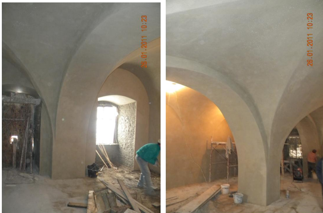
Tencuieli interioare pe nivelul III al Corpului A - MUZEUL CETĂȚII
